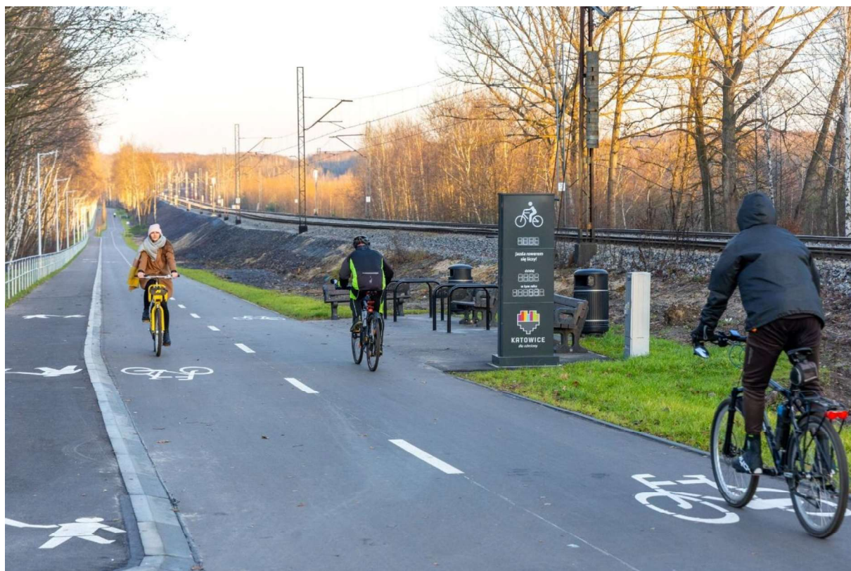
Fotografia 5.6 Odseparowana od ruchu samochodowego velostrada w Katowicach
