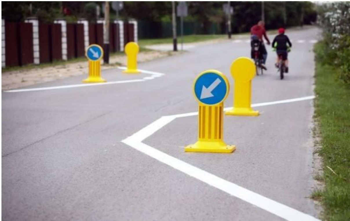
Rysunek 5.5 Stosowanie naprzemiennego zwężania jezdni – "esowania" w Stalowej Woli
