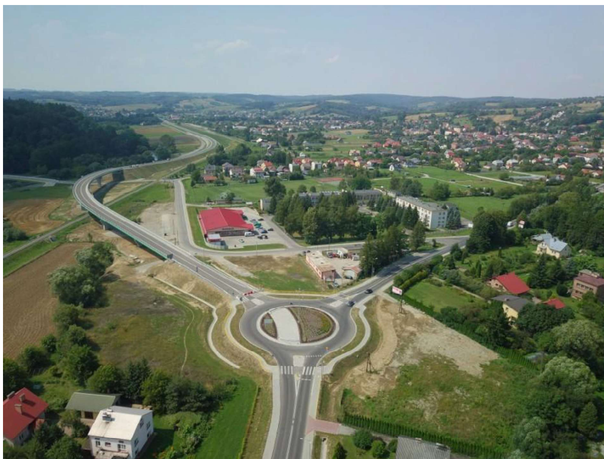
Fotografia 5.11 Obwodnica Czudca, przenosząca ruch tranzytowy poza obszar centrum
