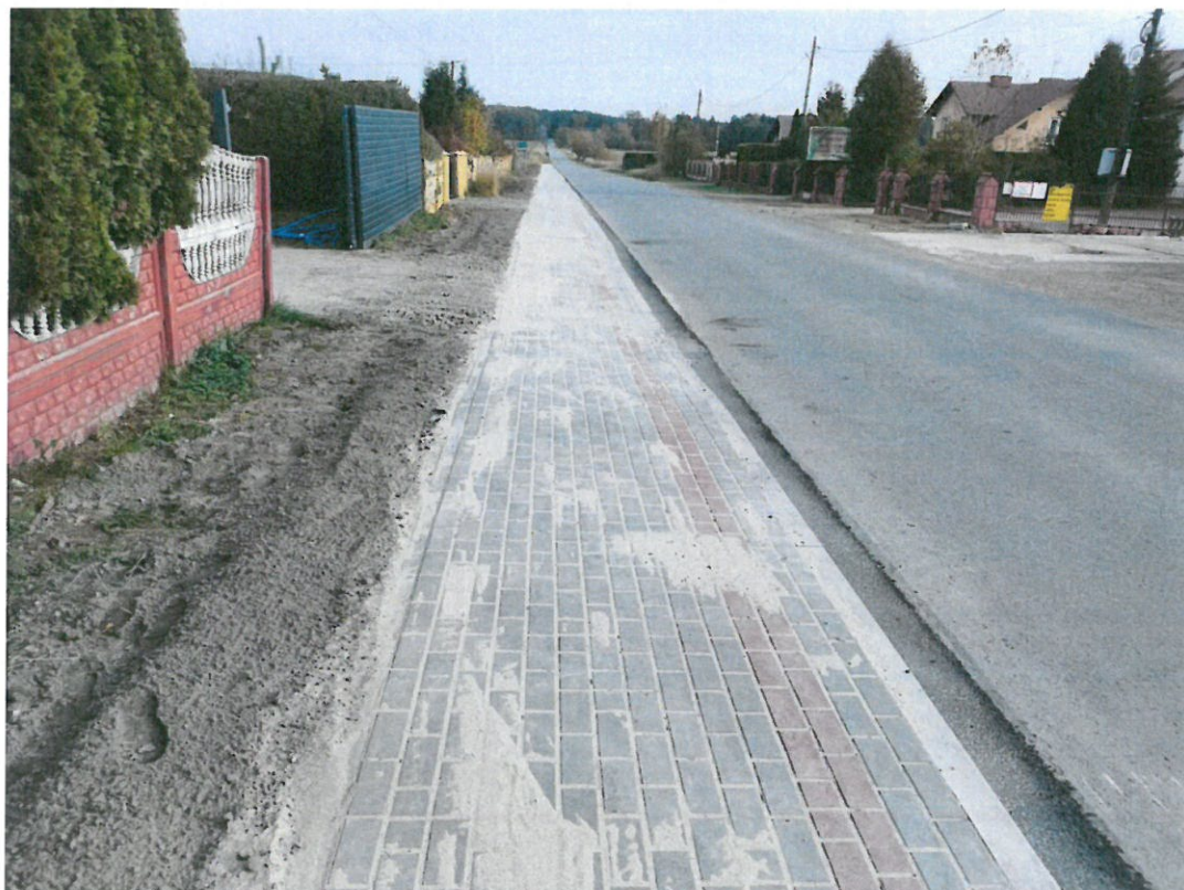
Droga powiatowa w Przewrotnem, w kierunku Pogwizdowa Starego
